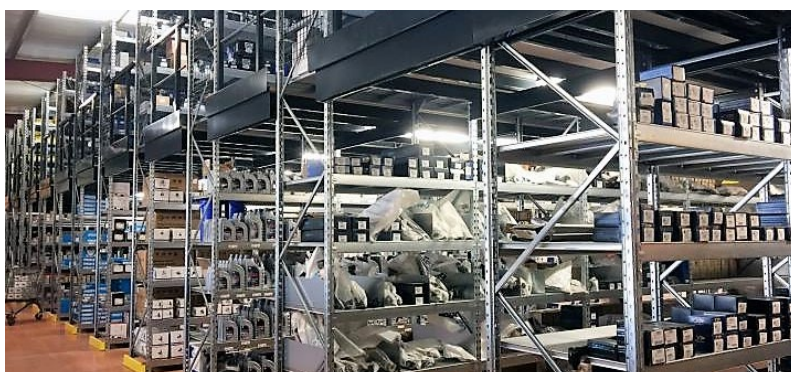
Passerelle sur rayonnage mi-lourd ...
